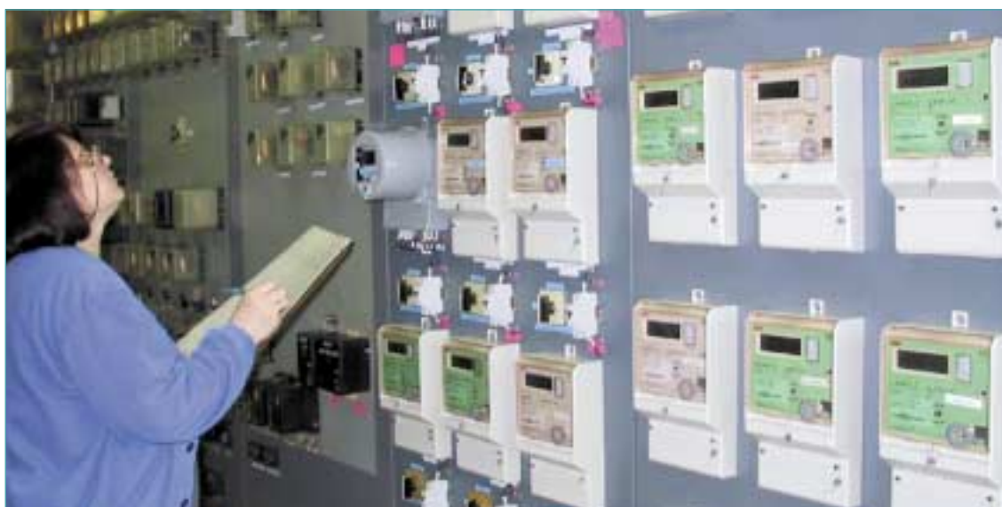
Електроенергията, произведена в АЕЦ и подадена в Електроенергийната система, се отчита чрез електромери, инсталирани в Окритата разпределителна уредба
